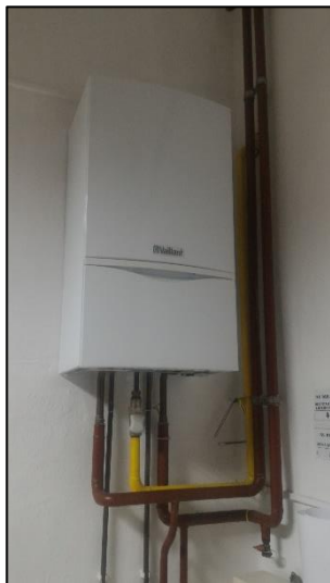
Slika 13. Plinski zidni bojler
